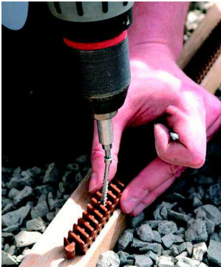
Abbildung: Montage einer Distalleiste
