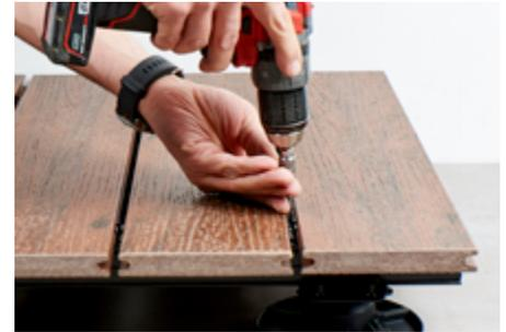
Wenn Dielen entnommen werden sollen, um zum Beispiel die Bodenlampen einzubauen, sind diese auch nachträglich noch zu lösen. Mit einem langen Bit kann man auch nach der fertigen Montage einzelne Dielen herausheben und wieder befestigen. Einfach die Schrauben in den Klammern entlang der Diele lösen und die zwei Dielen nach oben heben.
