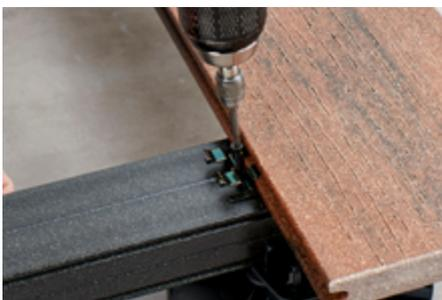
3. **Erste Montageklammer oder Systembefestiger einfügen und anschrauben.**
